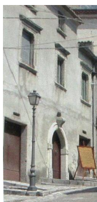
Veduta parziale del palazzo Marennna- De Nigris
