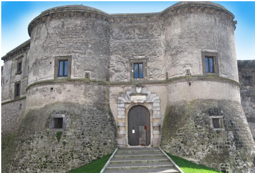
Facciata del Castello Ducale
