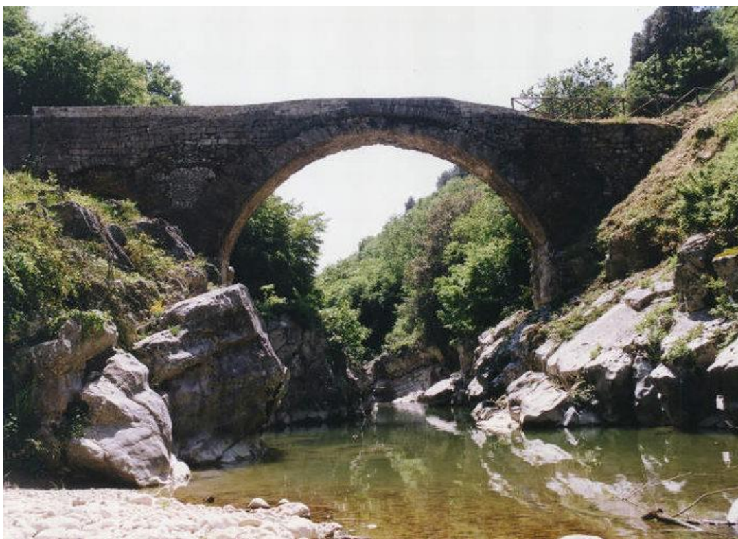
Il ponte Fabio Massimo prima della ristrutturazione
